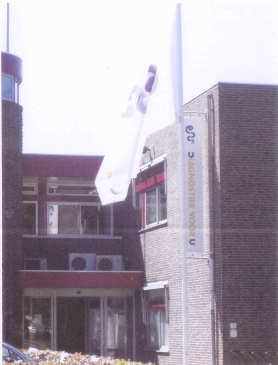
DIAGNOSTIEKVOORU LIGT IN EEN BUITENWIJK EN HEEFT RUIME PARKEERGELEGENHEID
